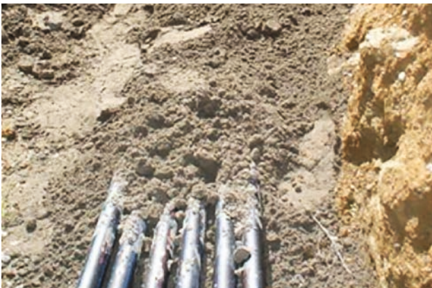
Tuyaux de raccordement posés sur un lit de sable
